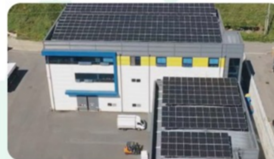
태양광 발전설비 (PV)
